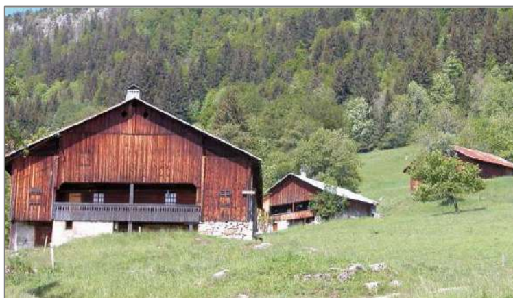
Figure 1 : Chalet d'alpage (Source : CAUE)
