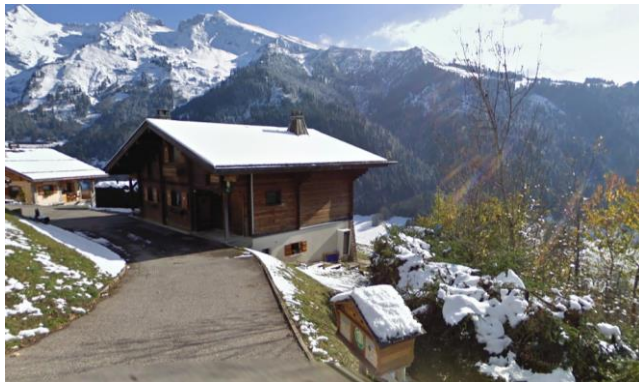
Exemple d'intégration dans la pente, Route de Plattuy La Clusaz Source : Google Map 2024
